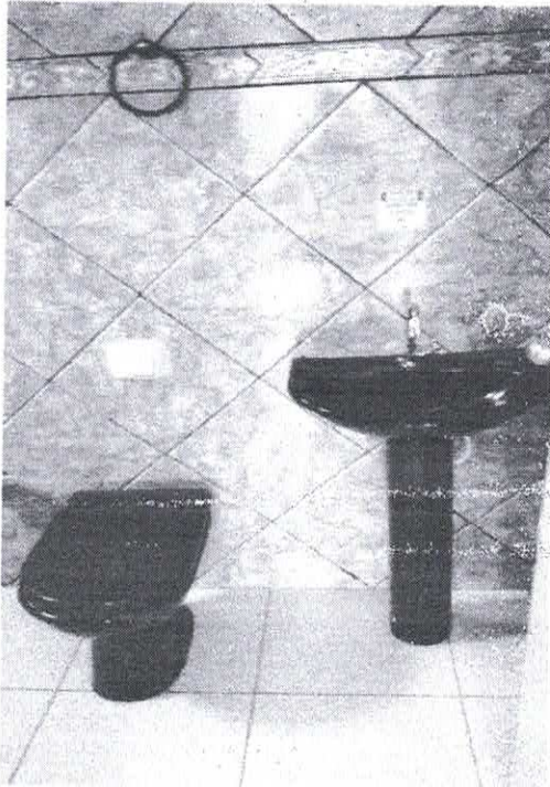
Foto 06, banheiro da suíte da casa 01
