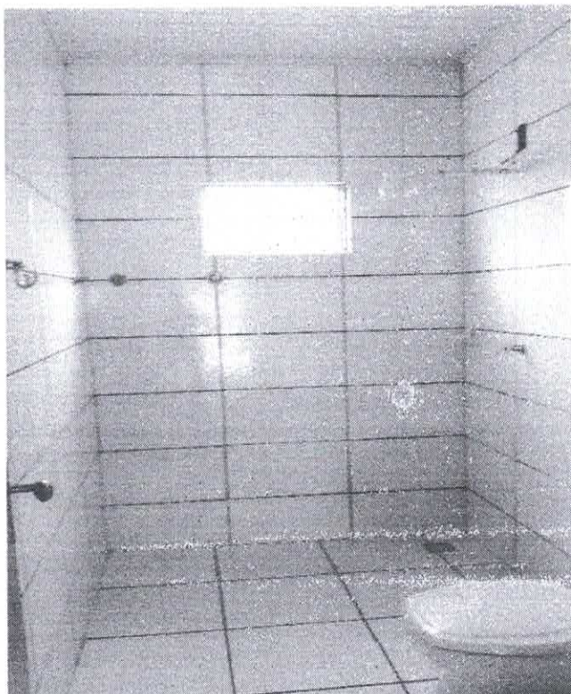
Foto 17, banheiro da suíte da casa 02
