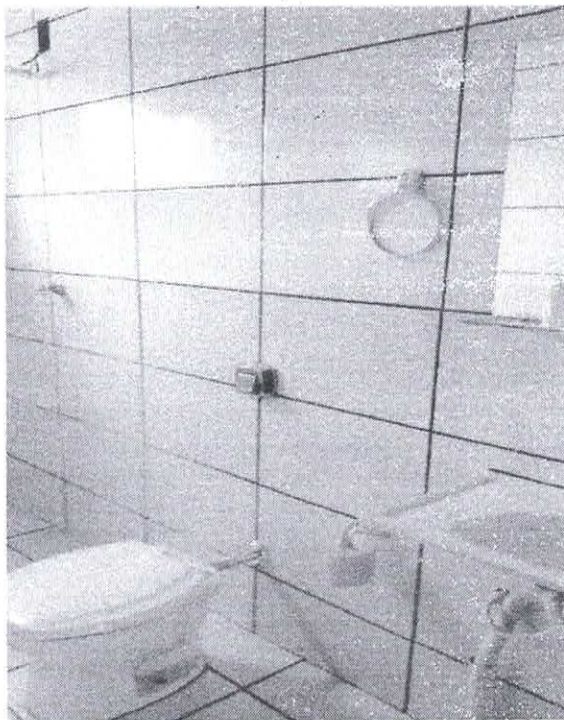
Foto 16, banheiro social da casa 02
