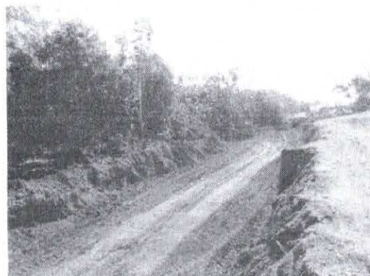
4B - Vista do local após as obras, ano 2019
