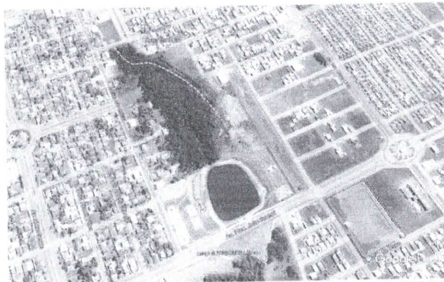
Figura 3 – Local sem interferência, porém com permanência de processo erosivo em destaque
