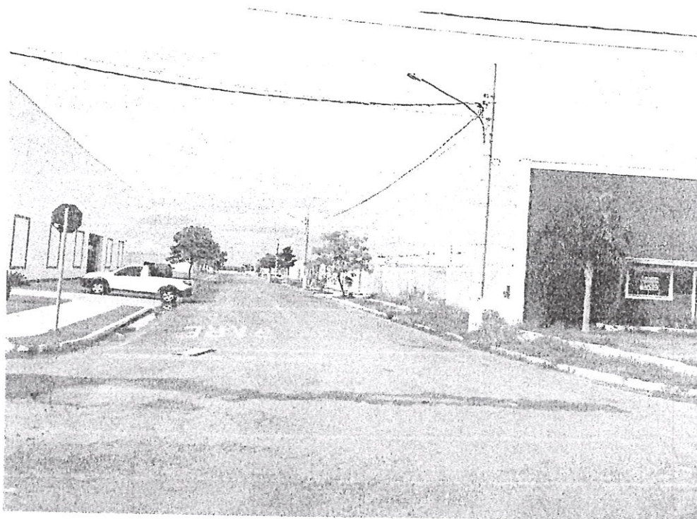
Vista da Rua no acesso ao Bairro
