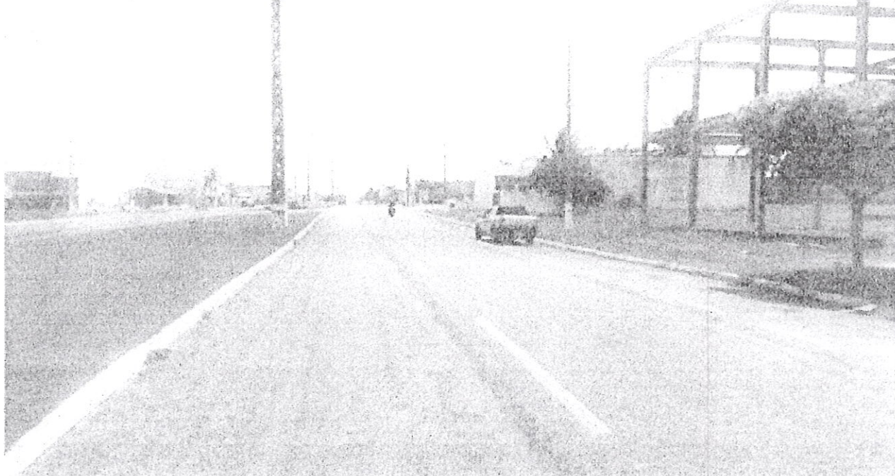
Foto Av. Campo Grande em frente ao terreno.
